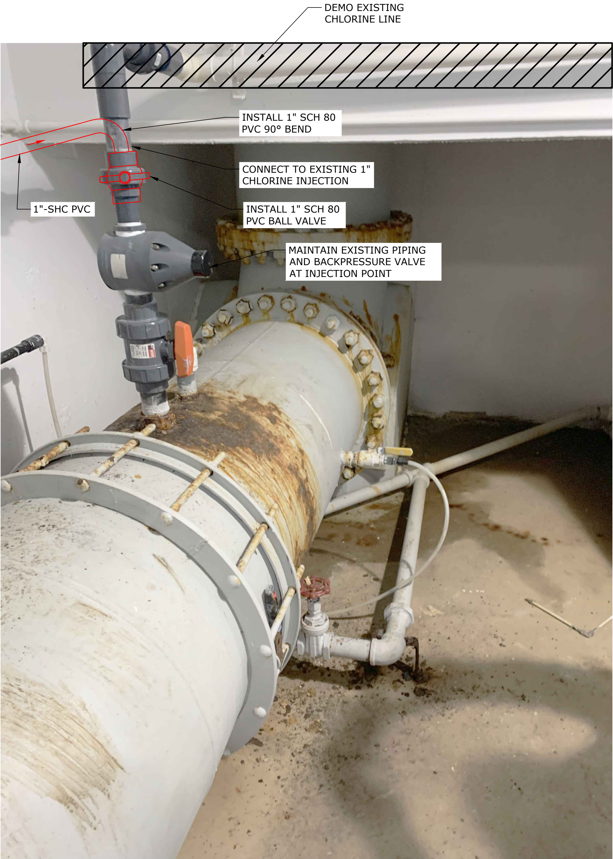
RAW WATER CHLORINE INJECTION POINT SCALE: N.T.S.
