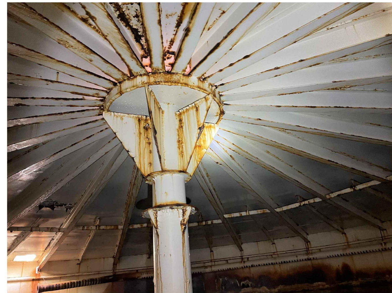
EXISTING COLUMN CAP
